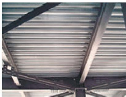
Le lamiere grecate sono rese collaboranti con il getto mediante impronte capaci di ancorare il getto stesso, impedendo sia lo scorrimento longitudinale che il distacco verticale.
