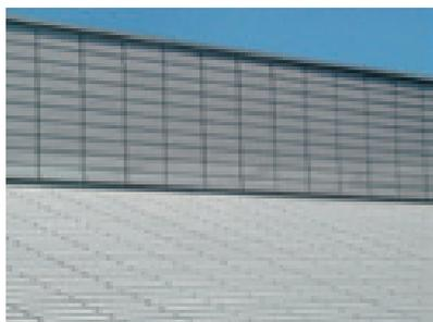
LARES dal nome latino beneaugurante che indica i Numi Tutelari della casa, è un sistema integrato innovativo per coperture e rivestimenti di pareti a manutenzione zero. Si tratta di sistemi di copertura modulari, montati a secco in cantiere, realizzando con un'unica posa lo strato impermeabilizzante, lo strato isolante termico ed acustico, lo strato di ventilazione.
